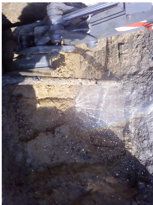
Vue de haut de fouille d'une réparation de fuite sur canalisation
