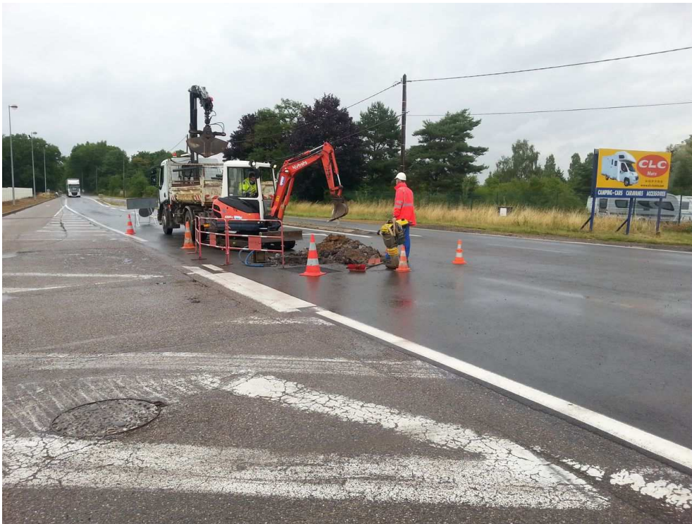
Opération de travaux neufs réalisée par la délégataire
