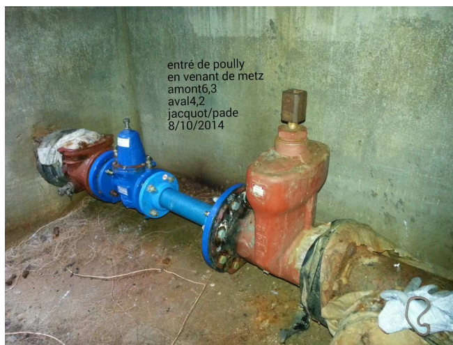
Remplacement du stabilisateur au niveau du regard - Réservoir de Fleury
