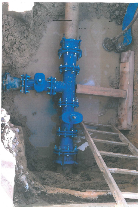
Raccordement sur canalisation amiante ciment rue Lorraine à Fleury
