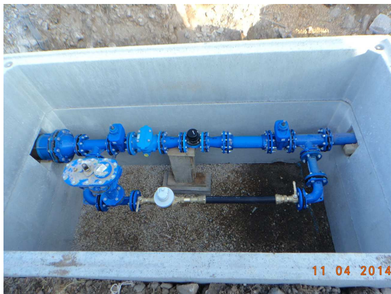
Création d'un nouveau regard équipé d'un comptage pour la sectorisation rue de Metz à Longeville les Cheminot
