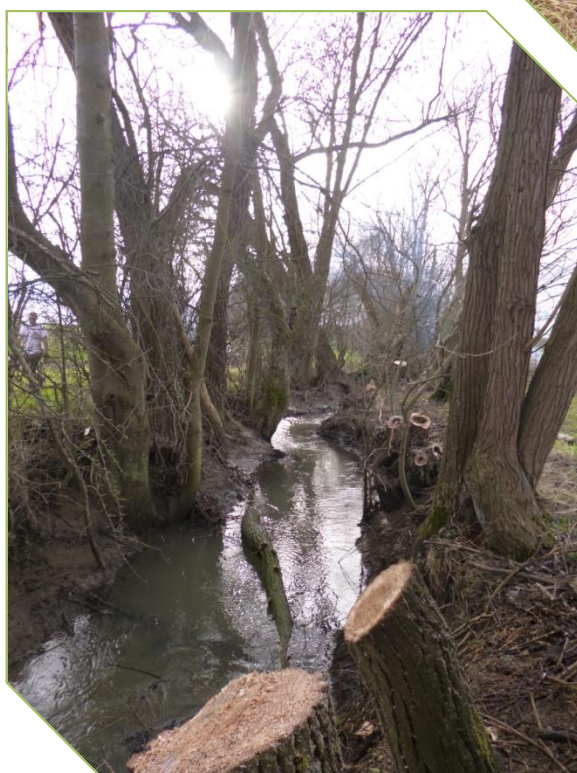
Figure 9 : Après travaux d'entretien de la ripisylve
